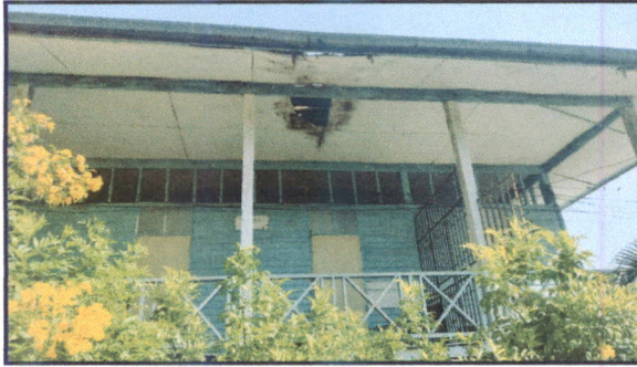
ภาพถ่ายด้านหน้าอาคาร
