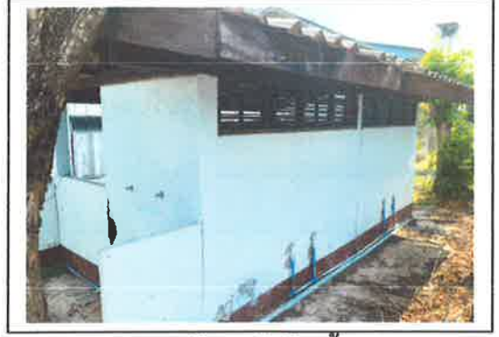
ภาพถ่ายด้านหลังห้องน้ำ
