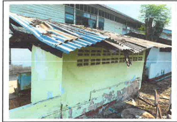
ภาพถ่ายด้านหลังห้องน้ำ
