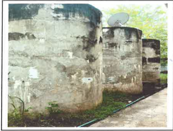
ภาพถ่ายด้านหน้าถังน้ำซีเมนต์
